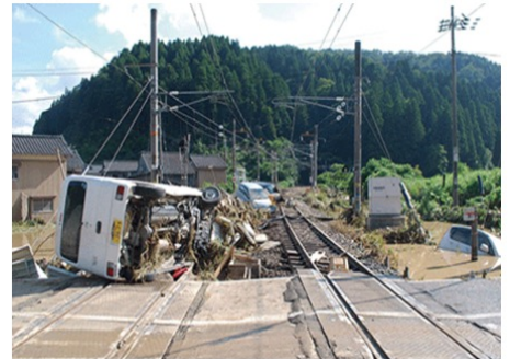
(写真3)令和4年8月の大雨被害
