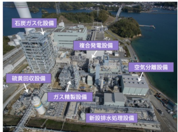
IGCC実証設備 プラント上空から
