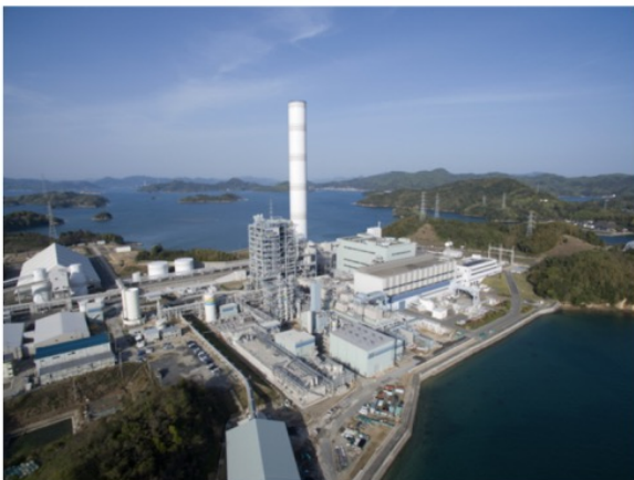
IGCC実証設備 プラント全景
