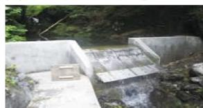
取水口から91mの落差で小水力発電をおこなっている。1000kw/hの発電が可能で村の半分の電力を賄える。
