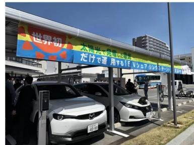
広島県に新たに登場した完全自立型ソーラーカーポート。自然エネルギーである太陽光発電のみの完全脱炭素での電気自動車(EV)への給電設備として注目されています。広島県立広島産業会館の駐車場に設置されています
